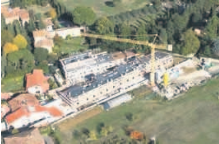
Uno dei cantieri di Quadra
